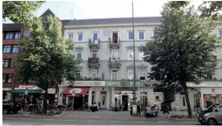
Wohn- & Geschäftshäuser in der Osterstraße
